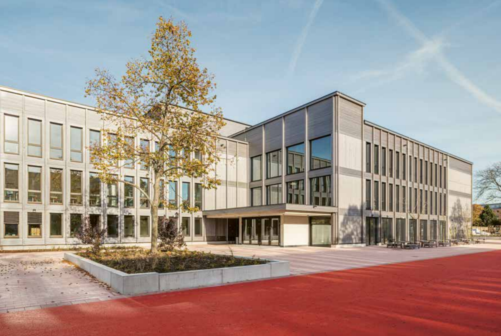
Le bâtiment scolaire de trois étages en construction modulaire/par éléments hybrides en bois dispose de 28 salles de classe, d'une cuisine et d'un réfectoire.
