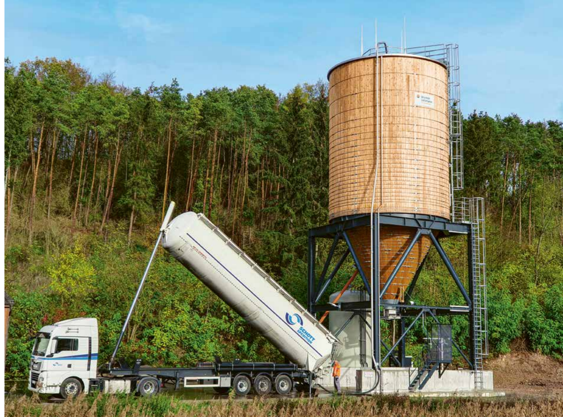
Remplissage du silo avec du sel gemme via le conduit de remplissage.
