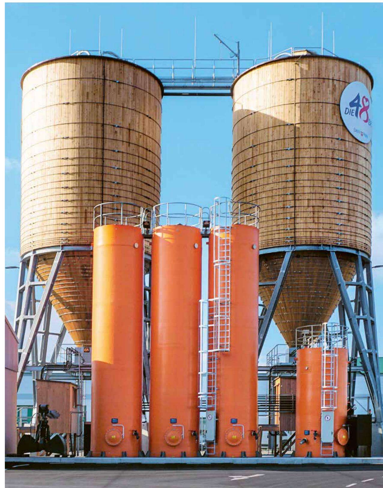
Вена (Австрия), 2 × 500 м<sup>3</sup> круглых силоса и 3 × 45 м<sup>3</sup> резервуара для хранения рассола с установкой по производству солевого раствора
