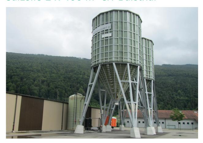
Diese Grosssiloanlage ist aus Mehrschichtplatten aus Fichtenholz gefertigt. Der Silounterbau ist in duplexiertem Stahl ausgeführt.
