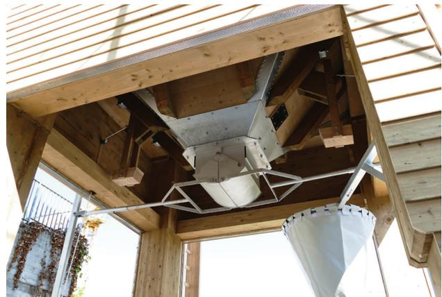
Dieses E4 Silo ist mit einer Trennwand ausgestattet, damit gleichzeitig Salz und Splitt gelagert werden kann (32 m<sup>3</sup> Salz, 18 m<sup>3</sup> Splitt).
