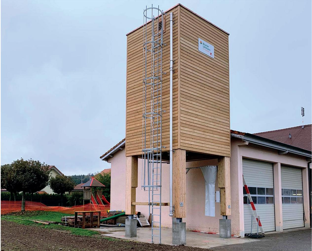
Salzsilo E4 mit Lärchenschalung und Stützenverkleidung mit diversen Zusatzelementen:
