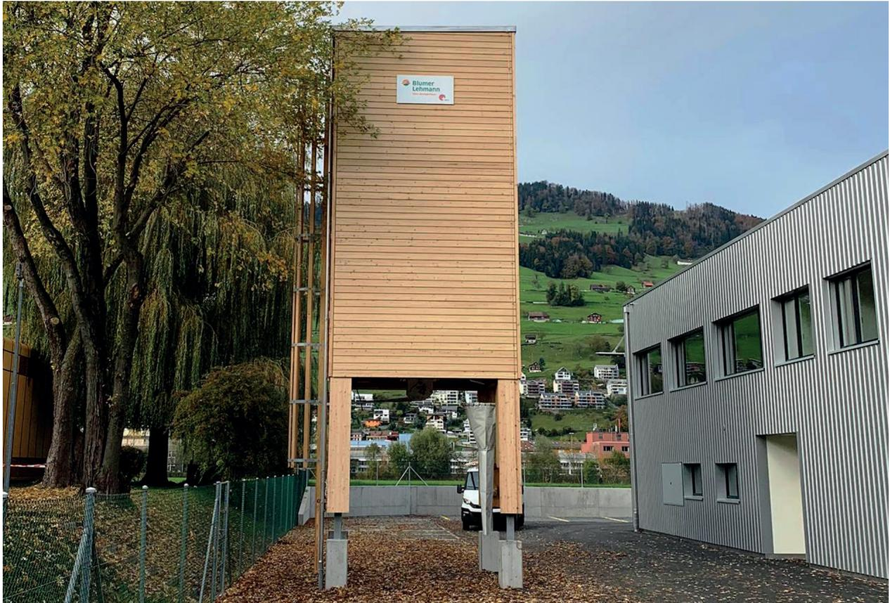
Freistehendes Salzsilo E4 mit Lärchenschalung und Stützenverkleidung mit diversen Zusatzelementen:
