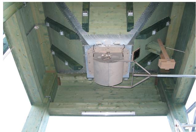
Der grösste je ausgelieferte E4 Silo wird komplett im Werk vorproduziert, mittels Spezialtransport geliefert und am selben Tag montiert.
