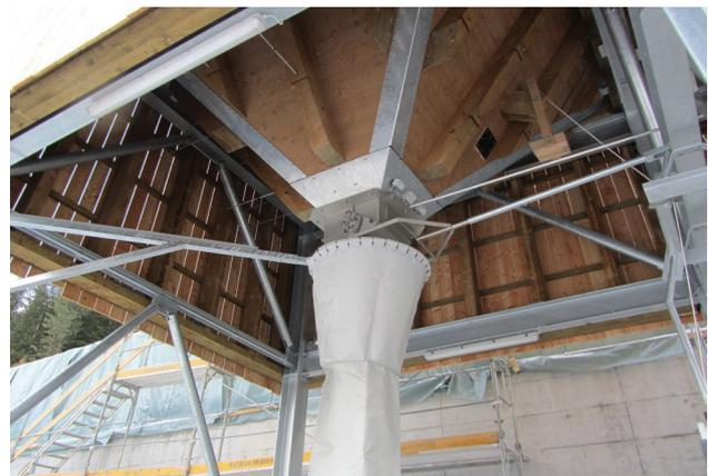
Die Streugutsilos in Modulbauweise wurden auf einem feuerverzinkten Stahlunterbau erstellt.
