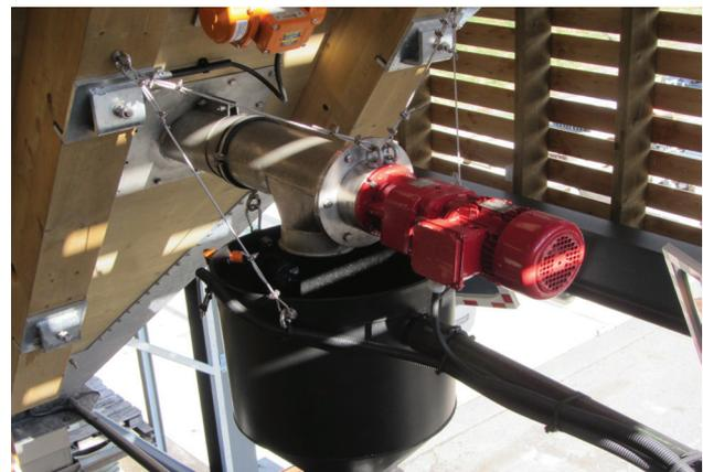
Aus Platzgründen ist diese Siloanlage direkt in den Vordachbereich der bereits bestehenden Halle integriert. Die Befüllung des Silos erfolgt ausschliesslich über die Förderanlage, welche ca. 40 m entfernt in der Salzhalle steht.
