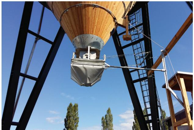
Streugutsilo in runder Bauweise aus Lärchenholz auf duplexiertem Stahlunterbau mit diversen Anbauten:
