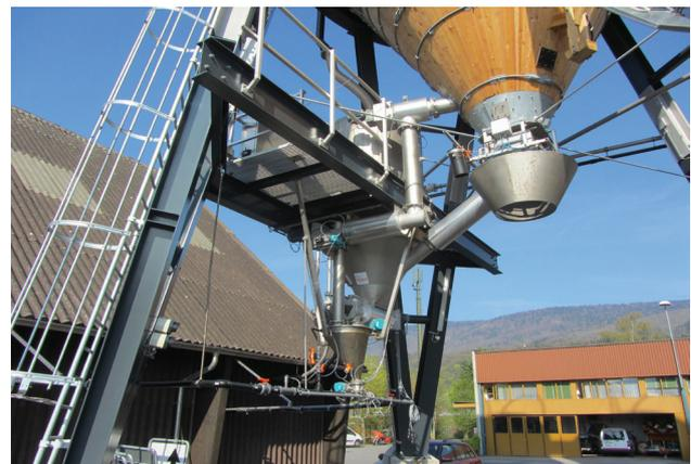
Bei dieser vollautomatisierten Siloanlage wurde ein Stahlsilo für Calcium an die Unterkonstruktion gehängt. Dies ermöglicht ein direktes Beimischen von Calcium zum Streusalz während des Entnahmevorgangs.
