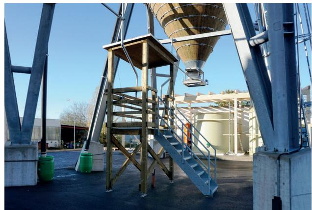
Streugutsilos in runder Bauweise auf feuerverzinktem Stahlunterbau
