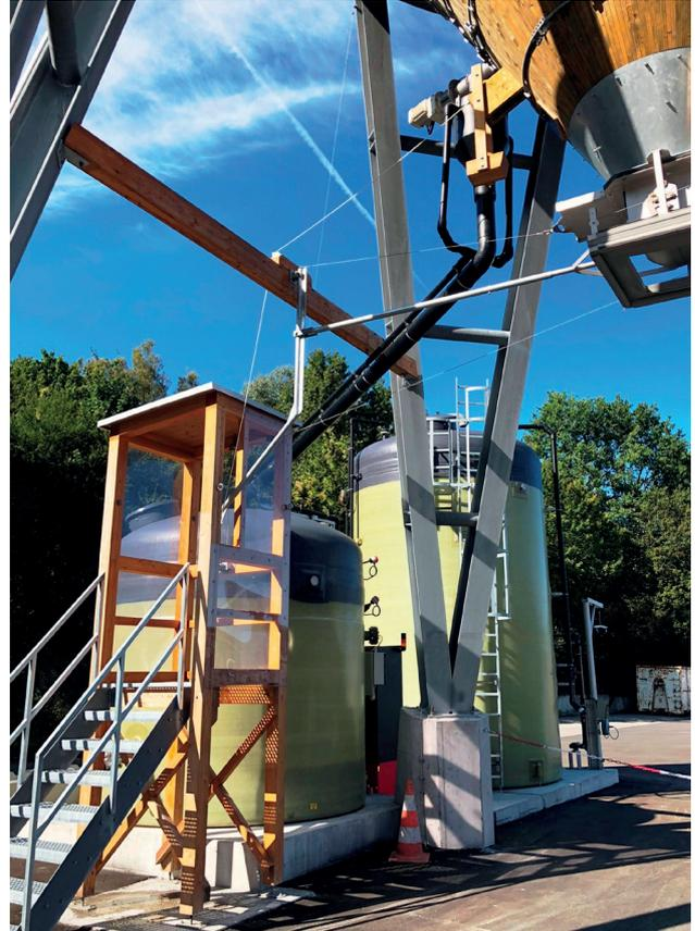
Siloanlage auf feuerverzinktem Stahlunterbau.
