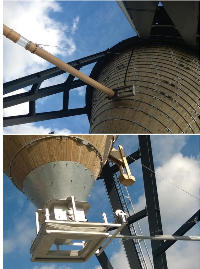
Der runde Silo ist auf 3-stieligem, duplexiertem Stahlunterbau errichtet.
