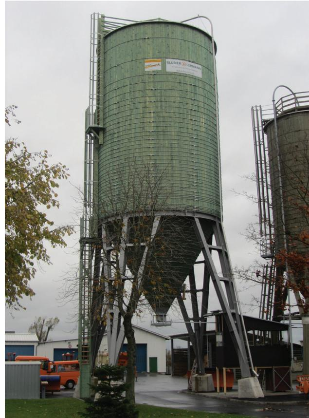
Mit seinem Volumen von 600 m<sup>3</sup> Salz ist dies der grösste aus der Familie der runden Silos. Die mächtige Stahlkonstruktion trägt ein Gewicht von über 700 Tonnen. Durch den grossen Durchmesser erscheint der Silo trotz der grossen Kapazität sehr elegant. Auf Wunsch des Kunden wurde das Bedienpodest bauseits durch den werkeigenen Holzbauer erstellt. Die Bedienung des Silos wurde daran angepasst und erfüllt einen hohen Bedienkomfort.
