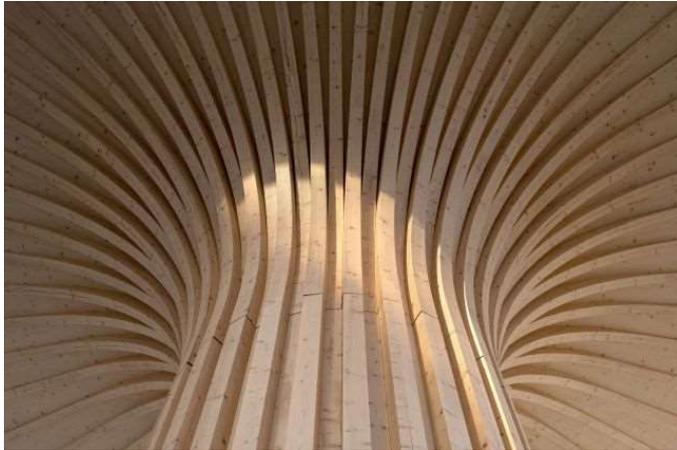
Gefertigt wurden die Verkleidungen aus Fichten-Brettschichtholz und Dreischichtplatten in den Werkstätten der Blumer-Lehmann AG. Das Free Form-Team des schweizerischen Holzbauunternehmens setzt ausgefallene Formen mit modernsten Planungs- und Produktionsmethoden in machbare Konstruktionen um – nach allen Regeln der Ingenieurs- und Holzbaukunst.
