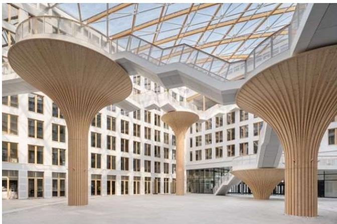
Blumer Lehmann war in diesem Projekt für die Planung und Umsetzung der Holzverkleidung für die vier baumartigen Stahlstützen verantwortlich, die im Atrium einen besonderen Eye-Catcher darstellen und die Podeste in luftiger Höhe über freischwebende Treppen miteinander verbinden. Die beiden Baukörper wurden in einer elementierten Holz-Hybrid-Bauweise nach dem CREE Buildings System errichtet.
