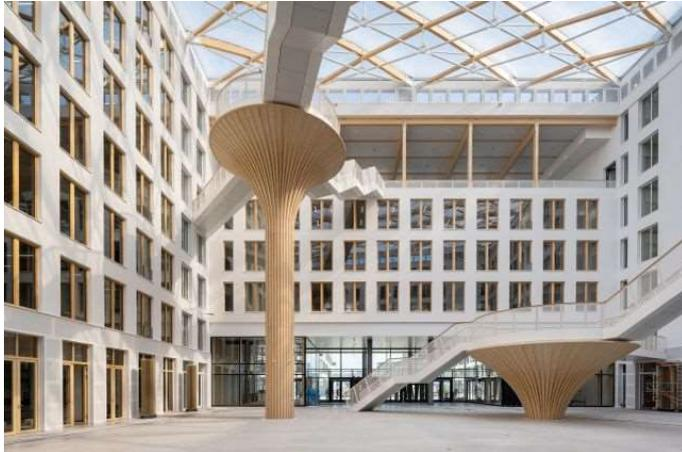
Die vier Büroriegel des Carré umschließen einen Innenhof mit einzigartiger Atmosphäre, der mit seinen der Natur nachempfundenen Stützen und einer luftigen Überdachung aus Folienkissen identitätsstiftend gestaltet ist. Der Baum als Spender des gebäudeprägenden Baumaterials Holz steht hier stofflich und symbolisch im Zentrum der Architektur.
