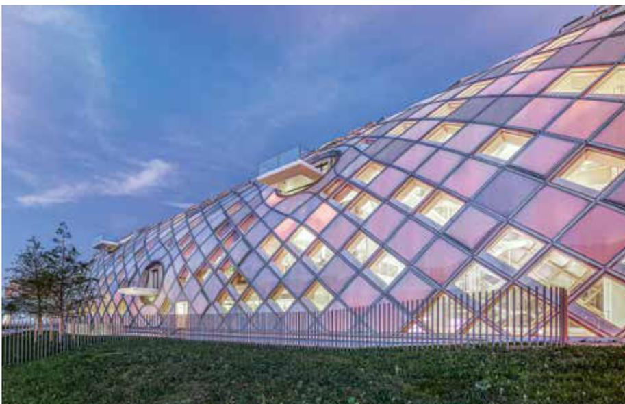
Die Hülle besteht aus verschiedenen Fassadenelementen: transparente Scheiben, Sonnenschutzelemente mit Sonnenschutzglas, Photovoltaik-Elemente und solche mit Luftkissen auf ETFE-Folie sowie akustisch wirksame Inlets aus Schweizer Kreuzen und einige großformatige Balkonöffnungen.
