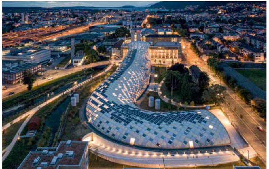
Das langgezogene Gebäude wird von einem riesigen gitterförmigen Tragwerk aus Holz bedacht, das mit einer Länge von 240 m, einer Maximalspannweite von 35 m und einer Höhe von 27 m gewaltige Ausmaße hat.
