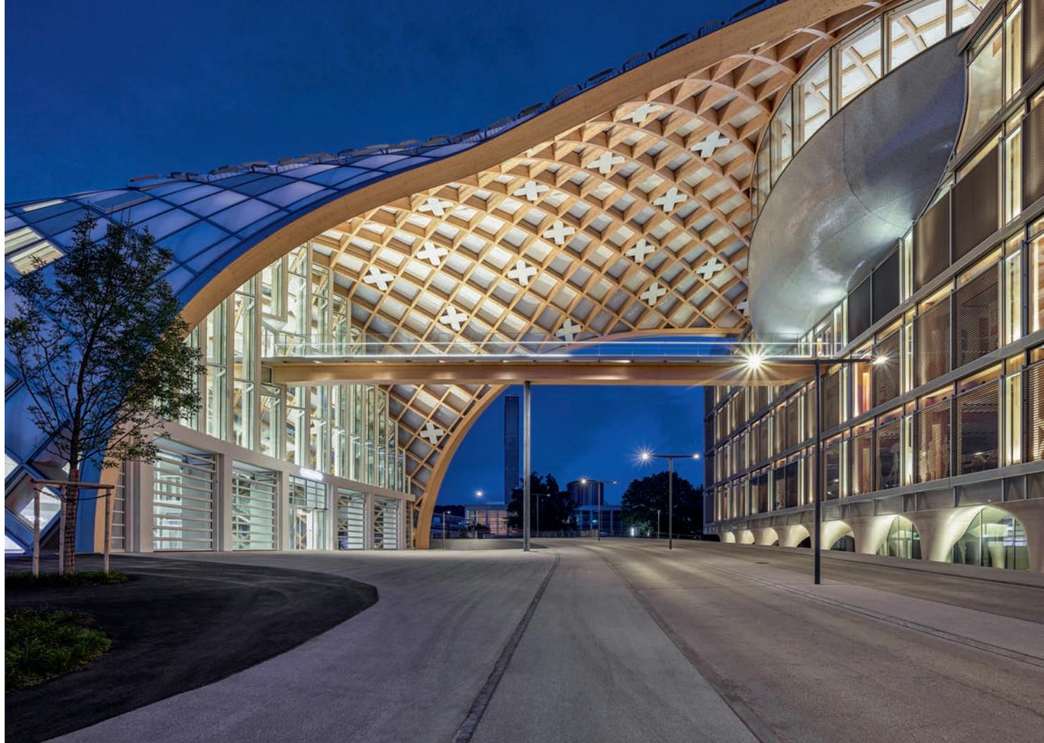
6 Die Fassade besteht zum grössten Teil aus insgesamt rund 2800 Wabenelementen. Jedes Element wurde aus bis zu 50 Einzelteilen massgeschneidert.
