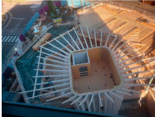
*Erst auf der Baustelle wurden die vorgefertigten Holzfinnen zusammengesetzt und biegesteif mit den Holzständerwänden der Pavillons verbunden.*
