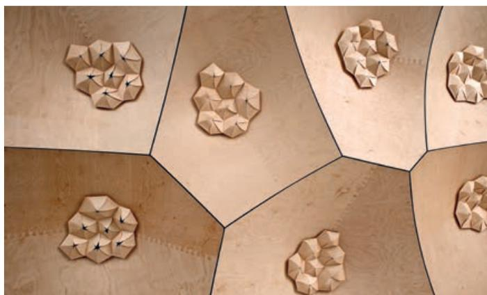
Bei hoher Luftfeuchtigkeit verformt sich das Holz von selbst, und die Klappen schliessen sich.
