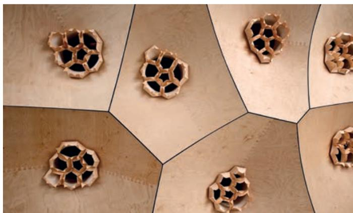
Bei tiefer Luftfeuchtigkeit öffnen sich die Klappen, sodass Licht und Luft ins Innere strömen kann.
