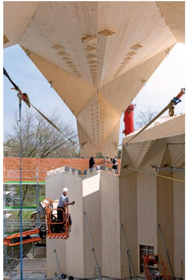
Die Montage erfolgte vor Ort, Reihe für Reihe – zuerst die vorgefertigten Wände und dann die 20 m langen vormontierten Dächer.
