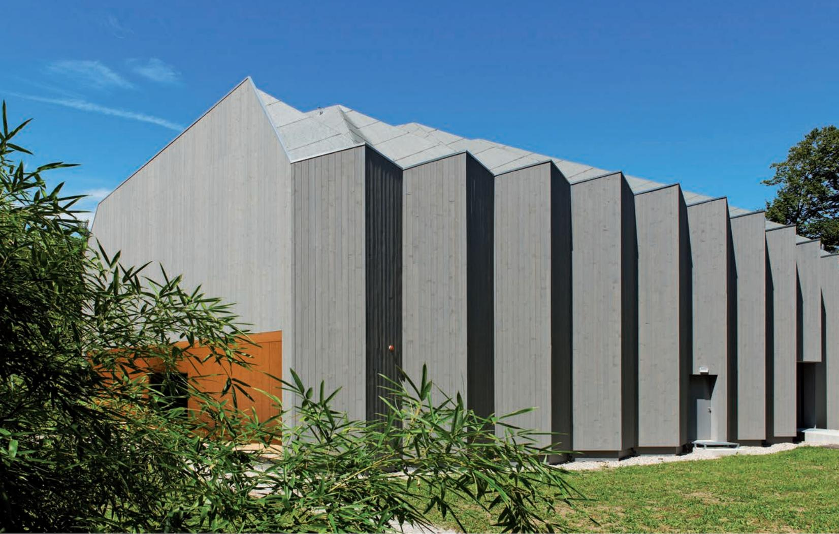
Die doppelt gefaltete Plattenstruktur wirkt integral als Gefüge, das insgesamt aus 22 Wand- und elf Dachsegmenten besteht.
