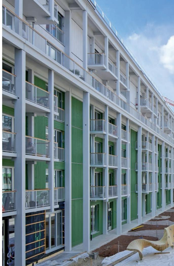
liegend, an der Fassade stehend – das Tragwerk. Das Deckensystem wird mit grossflächigen Brettsperrholzplatten, das Dachsystem mit Hohlkastenelementen ausgeführt. Die vorgefertigten Fassadenelemente sind geschossweise an den Unterzug aufgehängt. Der Baustoff Holz ist im Gebäude spürbar: Die teils freistehenden Stützen sowie Unterzüge und Decken sind bewusst in die Raumgestaltung einbezogen und gliedern die Grundrisse.
