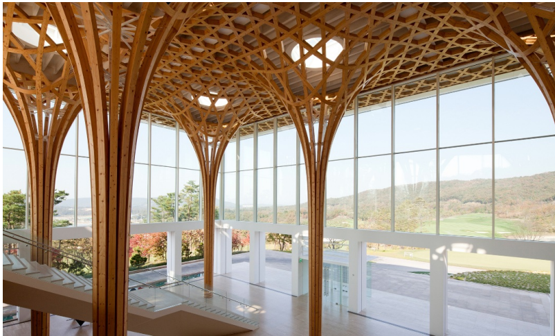
Blick auf das faszinierende Dachgewölbe
