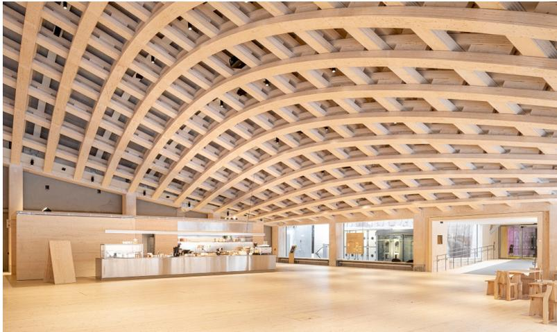
Das stützenfreie Free Form-Dach mit sichtbarer Gitterschalenskonstruktion aus LVL-Holz überspannt eine Fläche von 25 x 48 Metern.
