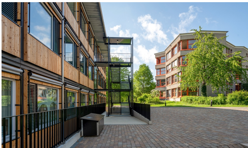
Les étages du pavillon scolaire sont reliés par un escalier externe.
