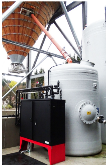
Runder Silo aus Holz auf einem kubischen und feuerverzinkten Stahlunterbau
